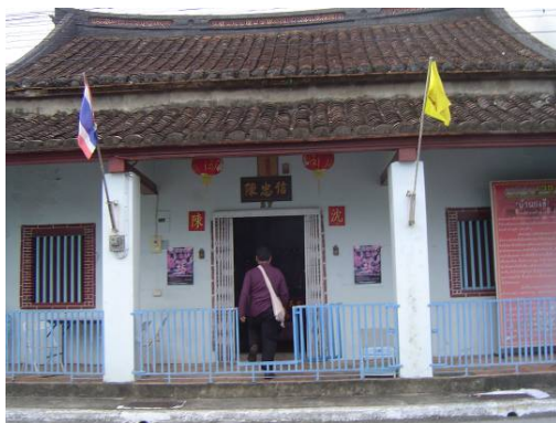
อาคารเก่าบริเวณถนนอะเนาะรู
